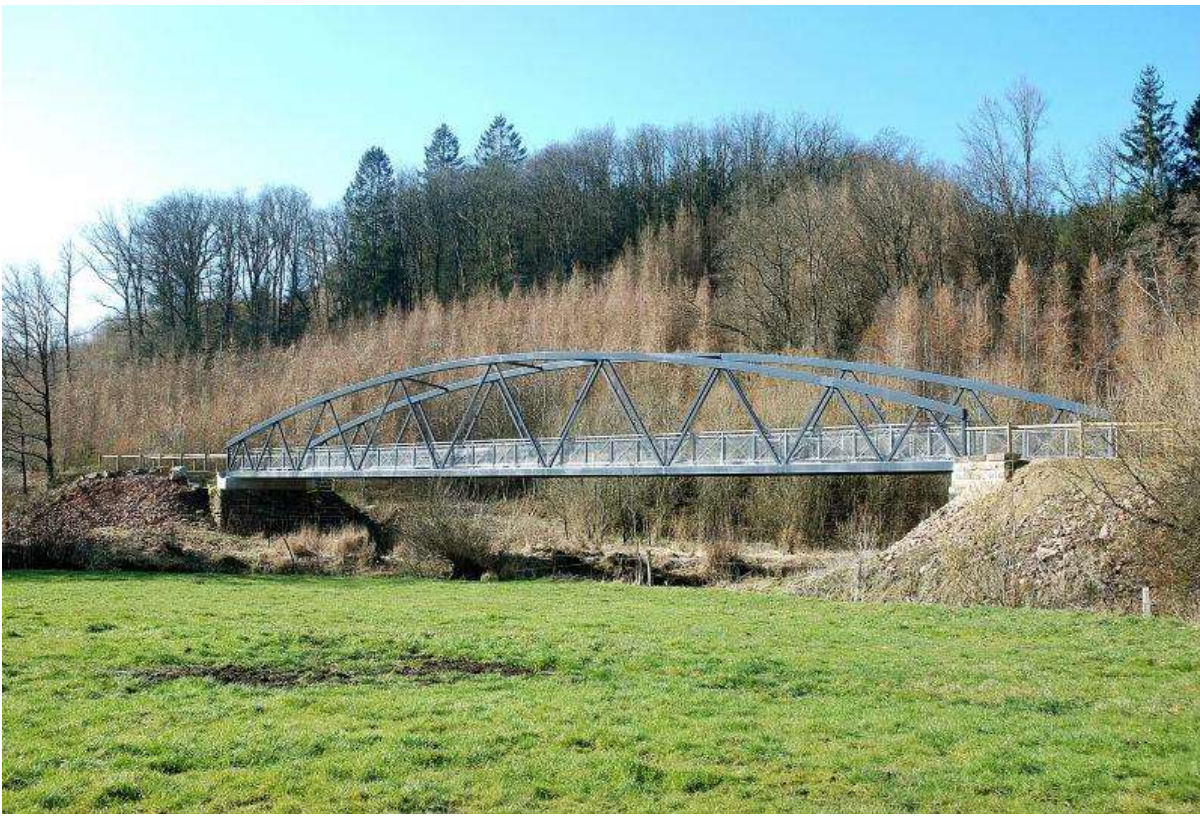
Die optimierte Streckenführung der Vennbahn im südlichen Teil zwischen Auel und Burg-Reuland mit der sehenswerten, neuen Brücke über die Our. | Foto: GE-Archiv
